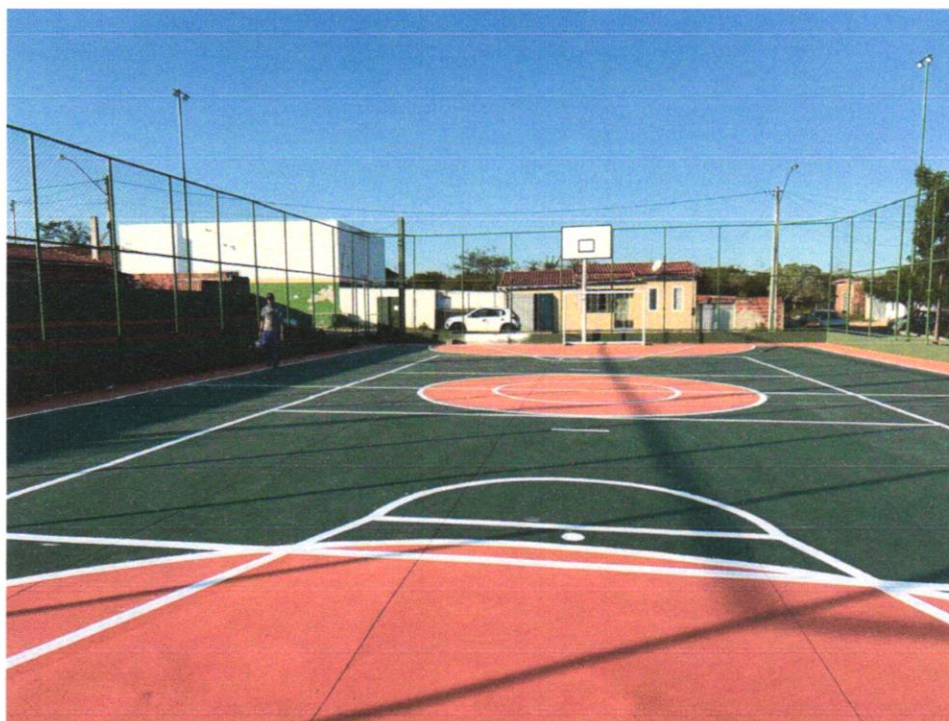
Foto 07 - PINTURA DE PISO COM TINTA ACRÍLICA, APLICAÇÃO MANUAL, 2 DEMÃOS, INCLUSO FUNDO PREPARADOR. AF_05/2021
